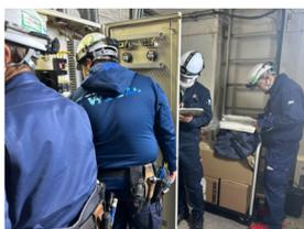
お客様が管理する建物の規模・用途に応じて、空調制御用のセンサー、調節計、操作器を設置、セットアップ調整します。空調制御の他、各種制御回路の設計施工を行います。
